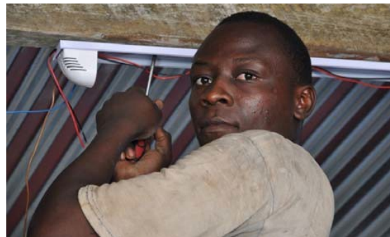
James bei der Elektroinstallation der Werkstatt
